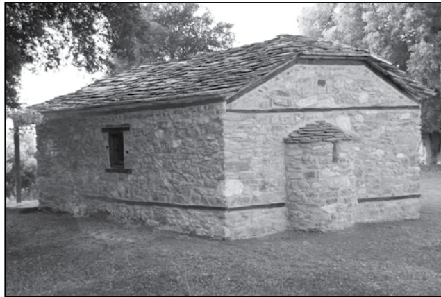
Ο προφήτης Ηλίας Παλαιοκάστρου, μετά την ολοκλήρωση των εργασιών αποκατάστασης του κελύφους.
